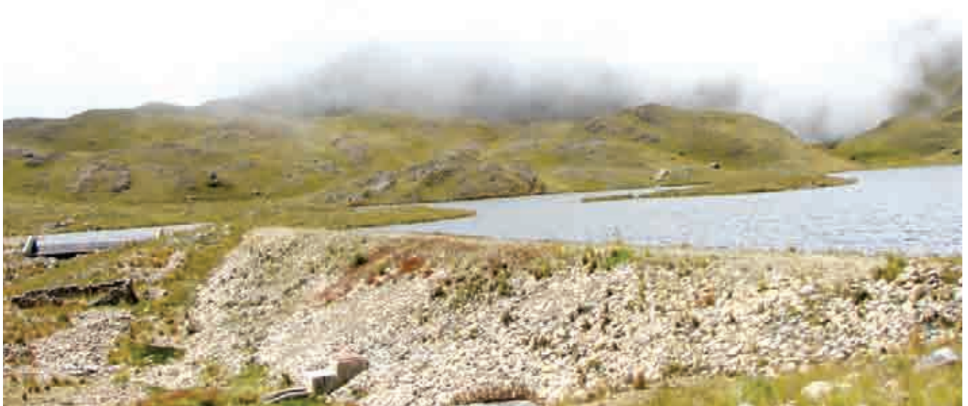
Vista del talud de aguas abajo del cuerpo de la presa, vertedero de excedencias y embalse Totorayoj
