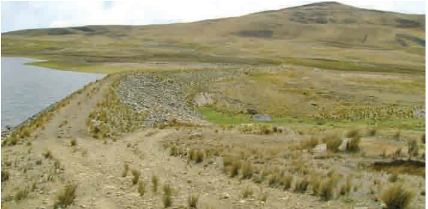
Vista del talud de aguas abajo del cuerpo de la presa, coronamiento y vaso de almacenamiento
