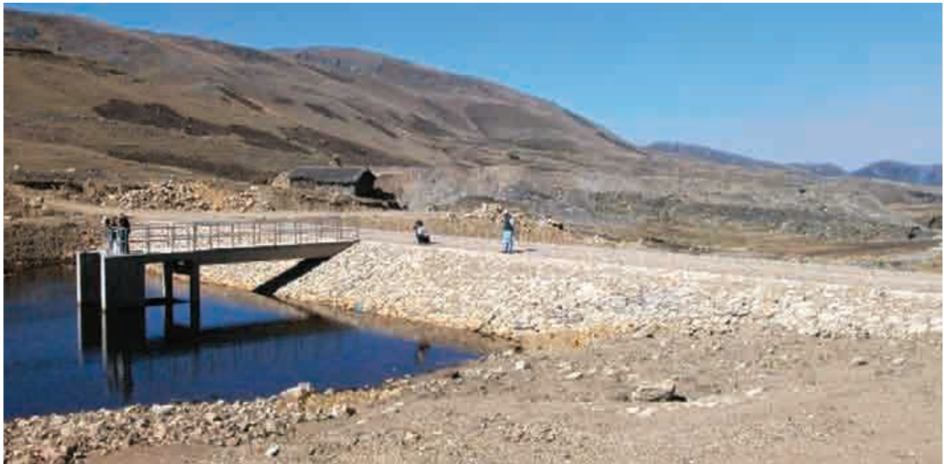
Vista del talud de aguas arriba de la presa y la obra combinada tipo torre en funcionamiento
