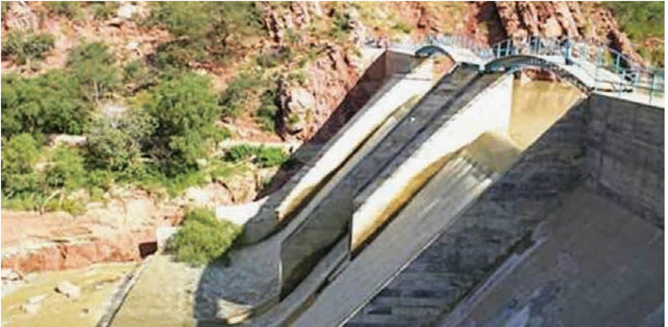
Vista aguas abajo del cuerpo de la presa y vertedor de excedencias en funcionamiento
