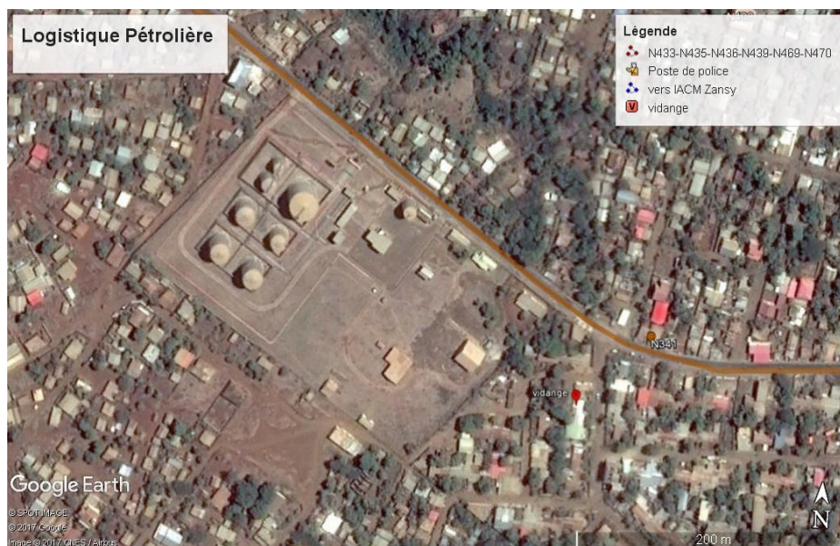
FIGURE 16 : TRONÇON DE RESEAU QUI PASSE DEVANT LE DEPOT DE CARBURANT DE LOGISTIQUE PETROLIERE S.A.
