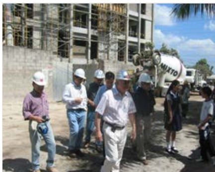
Hospital San Rafael. Misión del Banco Mundial supervisa obras en construcción.
