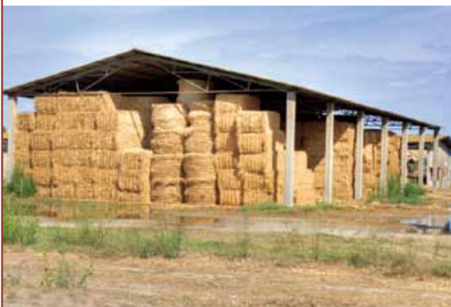
图 4.5 加利福尼亚的杆柱仓房，用作稻秆贮存
