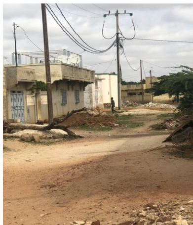
Photo 2 : Vue rapprochée du départ vers le poste de Mbour Sérère 3
