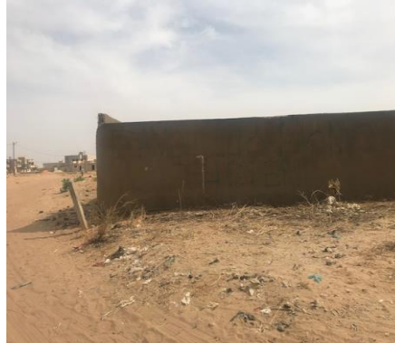
Photo 10 : Vue d'en face de l'emplacement du poste Cité Enseignant extension 1
