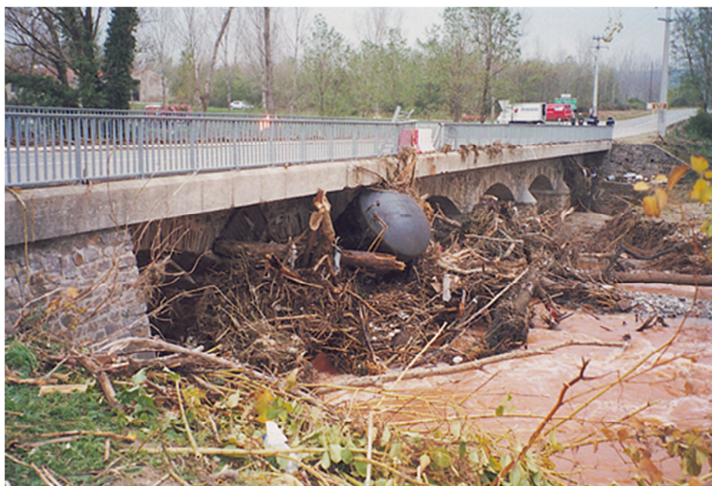
Exemple d'embâcle au droit d'un pont
