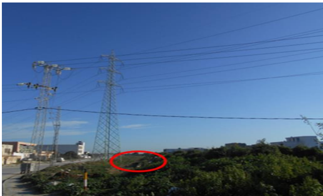
Figure 12:Mesure de sécurité pour éviter le pylône de la STEG
