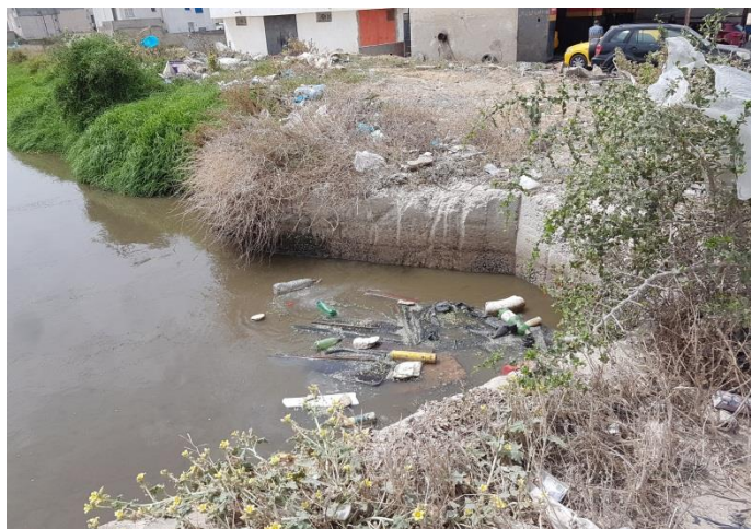
Figure 19: Accumulation des déchets dans le canal à ciel ouvert d'El Khelij
