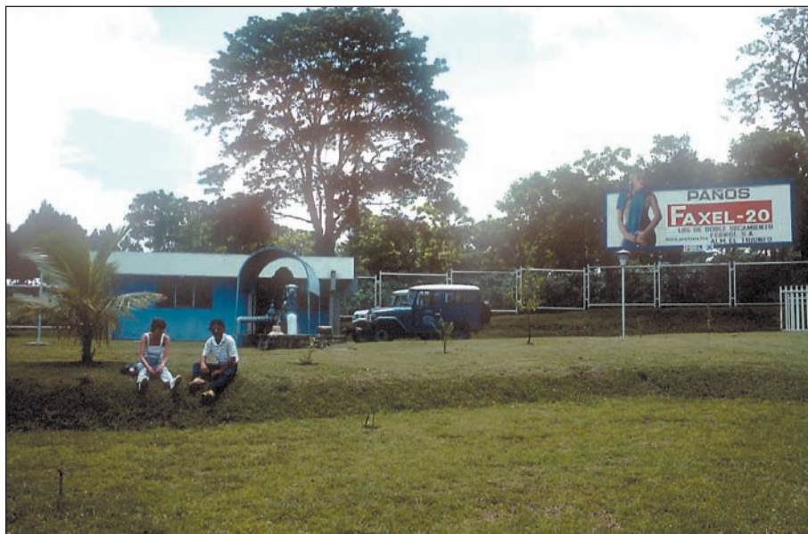
a) zona operacional bem projetada, com boas condições de drenagem e manutenção, em área rural arborizada
