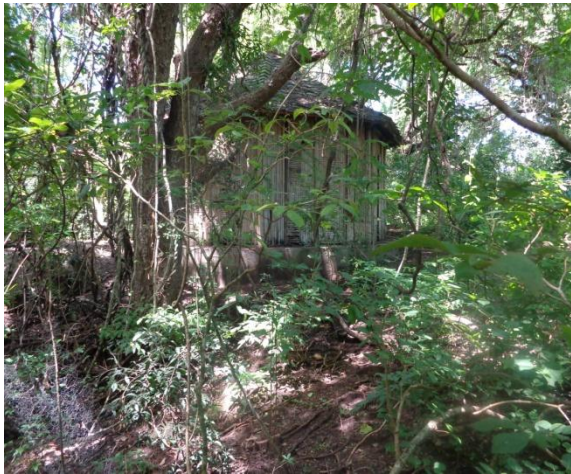
Photo 7 : Bâtiment d'accueil à réhabiliter
