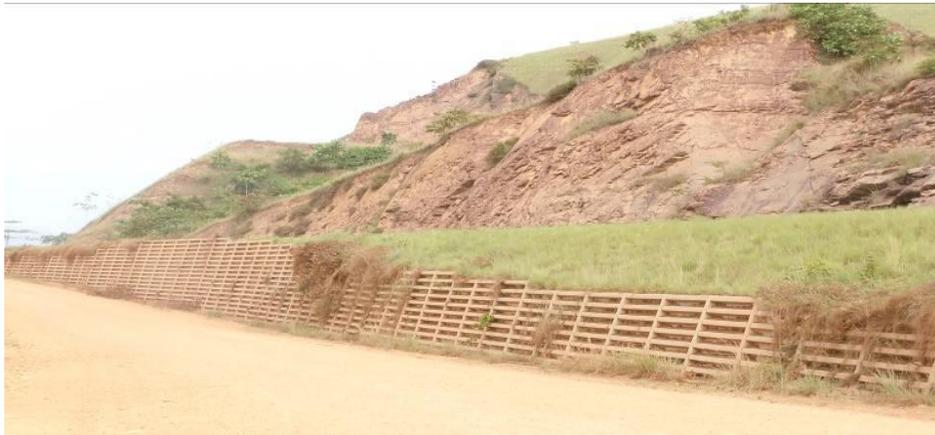
**Photo 2** Aperçu des ouvrages de stabilisation de la voie ferrée contre les risques d'éboulement
