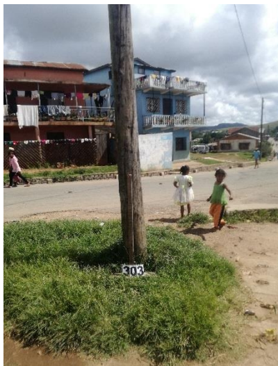
Exemple de poteau en bois existant à remplacer par un poteau en béton (Soavinandriana)
