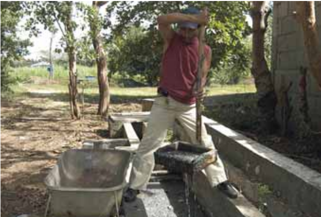
Operador limpiando natas flotantes y sólidos gruesos en el canal de entrada
