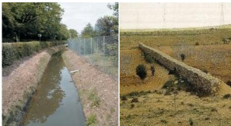
Seuils de rétention dans les oueds et le Tensift pour favoriser l'infiltration. La conception des seuils doit tenir compte des expériences antérieures, en particulier concernant les problèmes de colmatage. La construction d'une centaine de seuil permettrait d'améliorer le volume infiltré d'une cinquantaine de m<sup>3</sup> par an.
