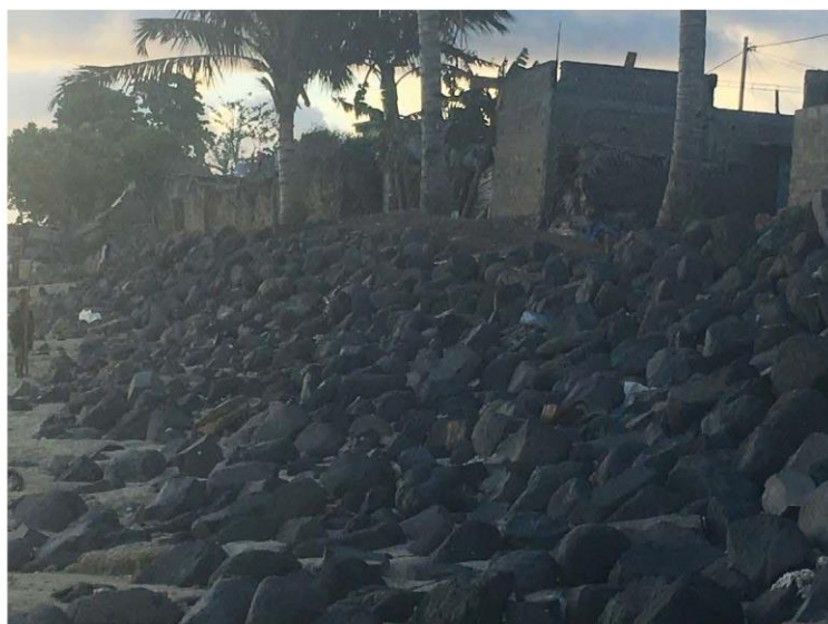
Les maisons d'habitations implantées à proximité immédiate des côtes et le système d'enrochement effectué par les femmes MTSANGANI à Nioumachoi
