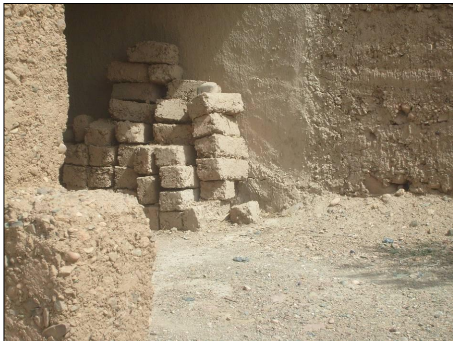
Photo 35 : Stock de briques fabriquées par la terre et la paille
