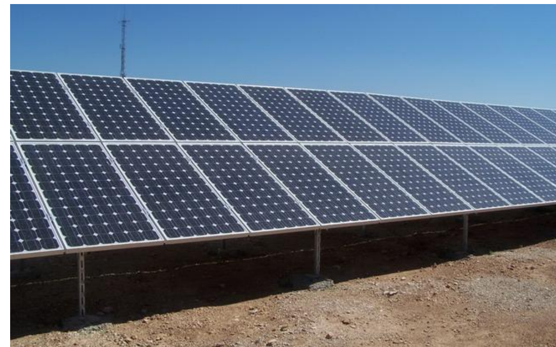
Figure 13 : Module utilisant des cellules monocristallines
