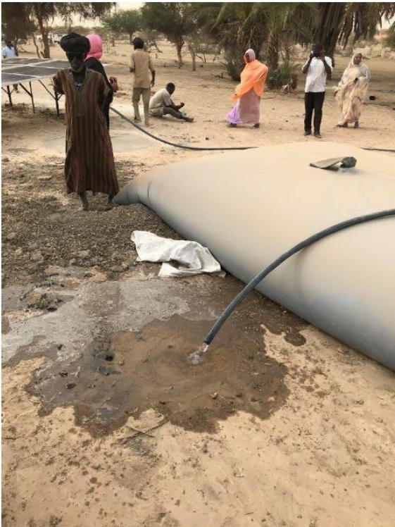
Maraichage - panneau solaire et réserve d'eau
