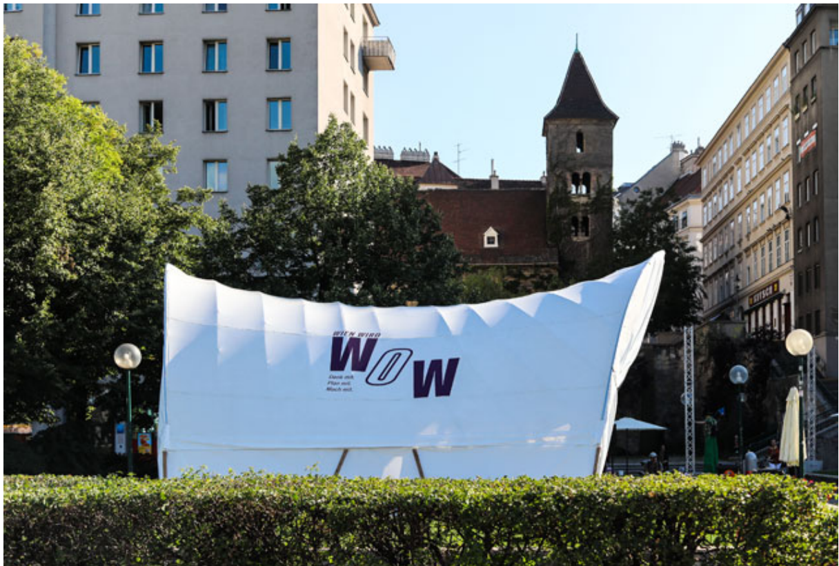
Figure 31: Wien wird Wow exterior in Vienna, Austria. Source: Stadtentwicklung Wien 201.8
