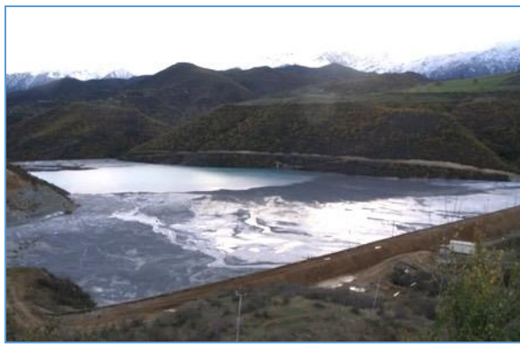
Վերընթաց բարձրացման պոչամբար ԱԹԴ-ի նշաններով պոչամբարի պատի վրա (աջից, Լոռու մարզ):
