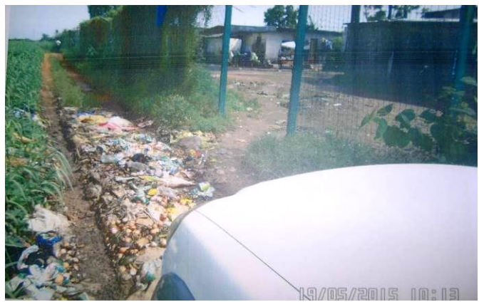
Création des dépôts de déchets sur la piste par les riverains installés à proximité de la clôture
