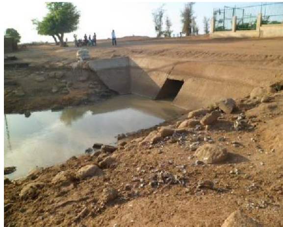
Figure 15: Ouvrage de prise de Doumaraye
