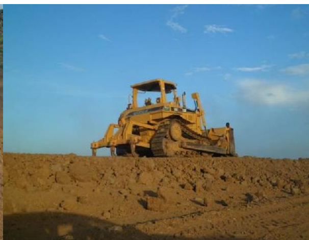
Figure 19: Un engin de la SEMRY en pleine activité de réfection de la digue
