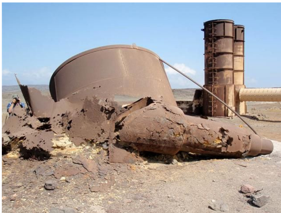
Installations techniques utilisés pour l'essai d'entartrage en 1990
