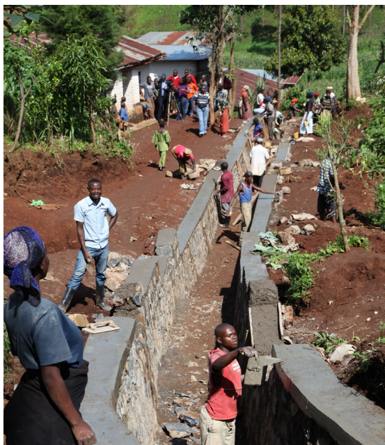
Construcción de un canal de agua en Rusizi, Ruanda © ONU-Habitat/Julius Mwelu
