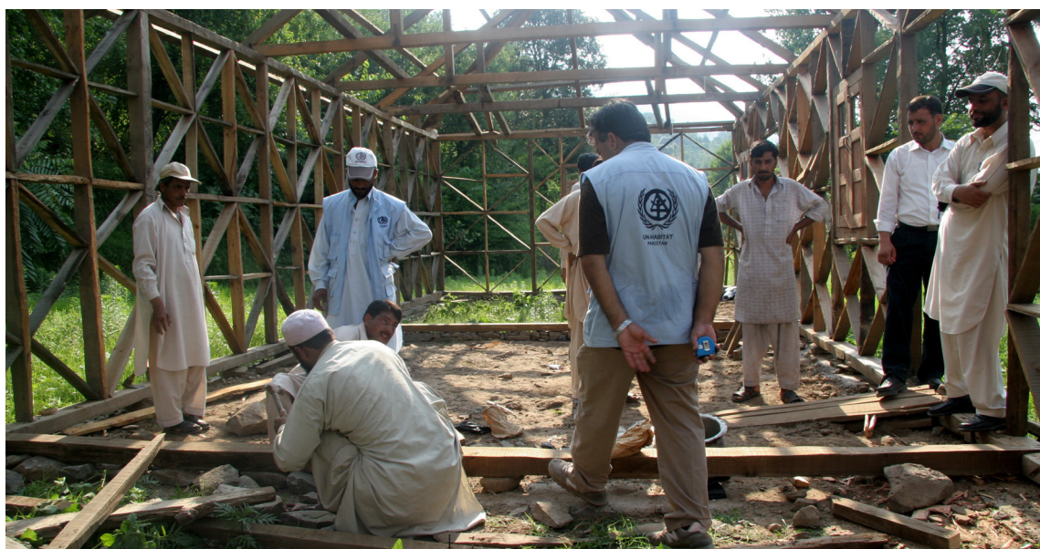
Reconstrucción de Vivienda en Bagh, Pakistán © ONU-Habitat
