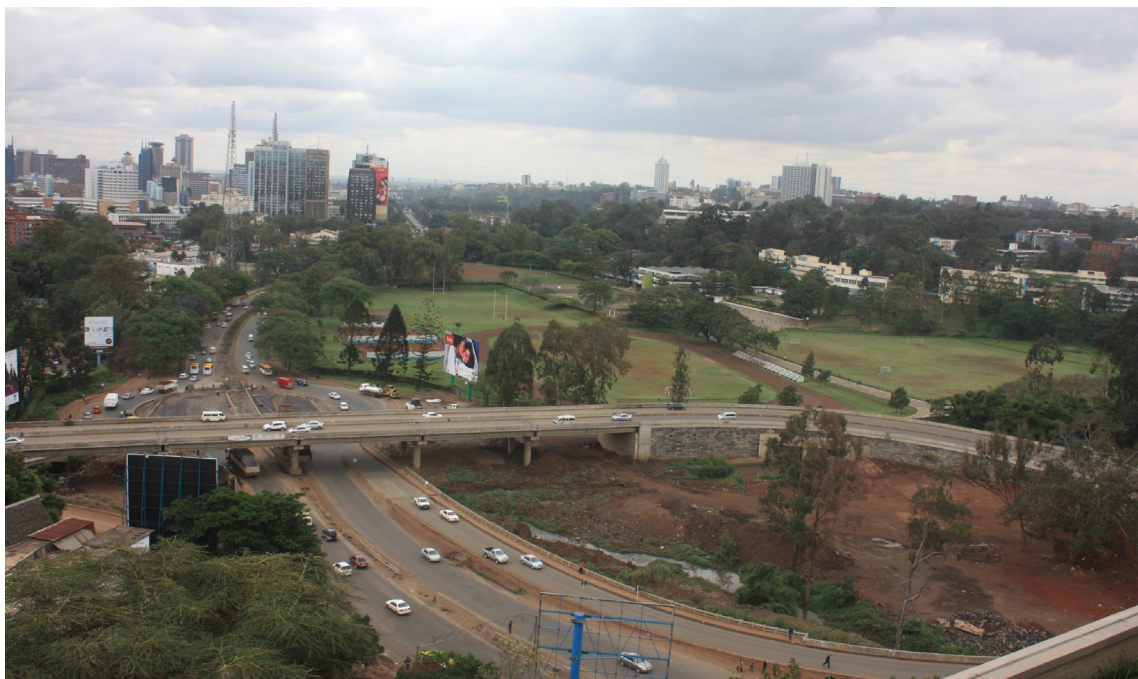
Construcción de infraestructura en Nairobi, Kenia © Kenya Vision 2030
