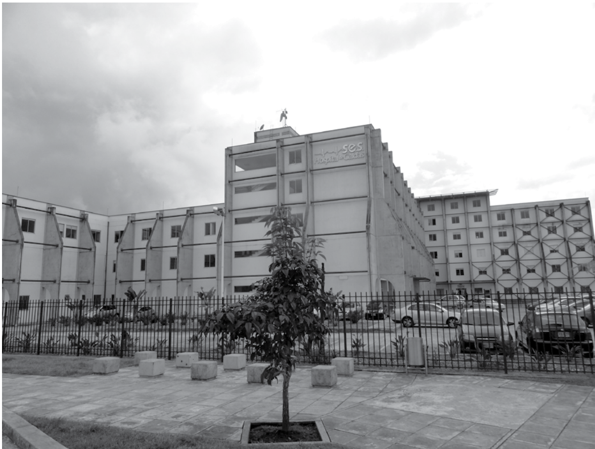
Reforzamiento Hospital de Caldas. Municipio de Manizales (Caldas). 2011. Fotografía cortesía de: Dora Catalina Suárez
