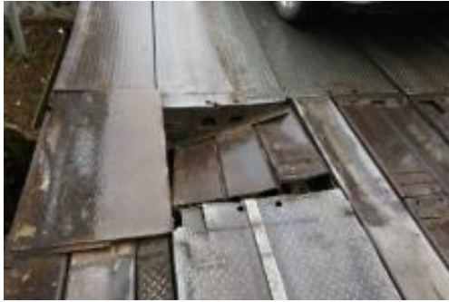
PHOTO 1 : PONTS DEGRADEES PAR DES SURCHARGES
