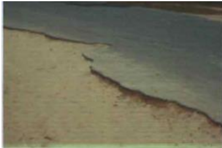
PHOTO 16 : ÉPAUFRURES DE GRANDE AMPLEUR - RN7
