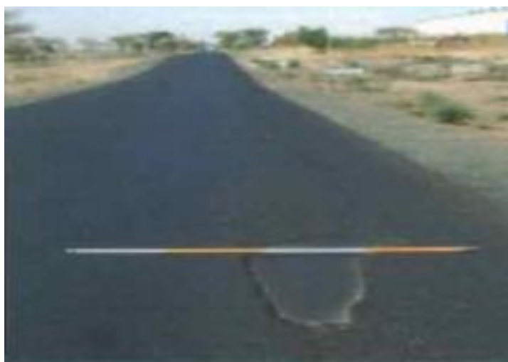
PHOTO 14 : EXEMPLE DE PELADE (RN7)
