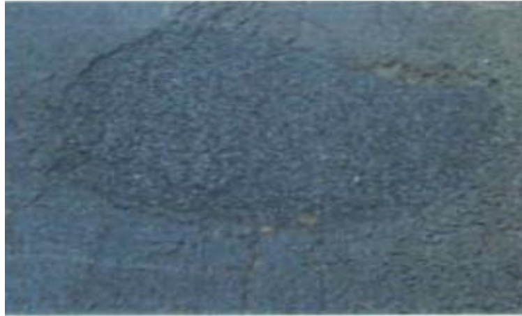
PHOTO 17 : EXEMPLE DE REPARATION (RN2)
