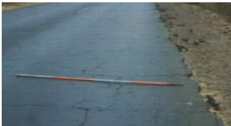
PHOTO 11 : DEBUT DE FAÏENÇAGE SUR LA RN2
