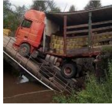
PHOTO 1 : PONTS DEGRADEES PAR DES SURCHARGES
