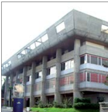
Photo 8: La Banque Centrale
