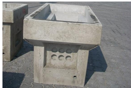
Photo 1 : Exemple de regard de tirage liaison double terne triphasée
