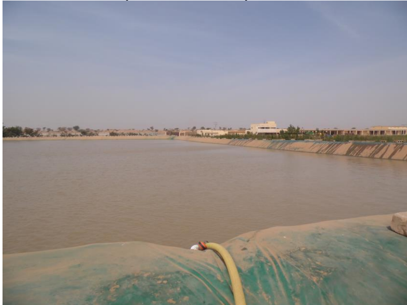
Photo 4 : Bassin de reprise à l'intérieur du périmètre horticole de SERIC
