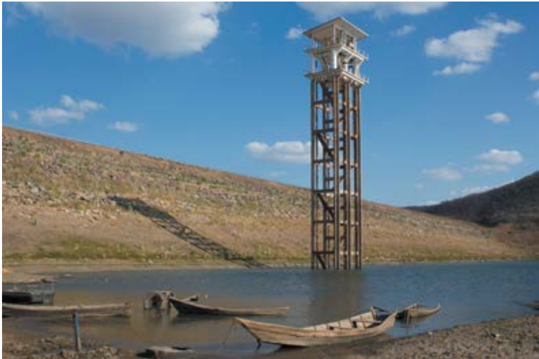
Foto 23 – Barragem e Torre do Açude Banabuiú. Crédito: Juliana Lima Oliveira (Funceme).
