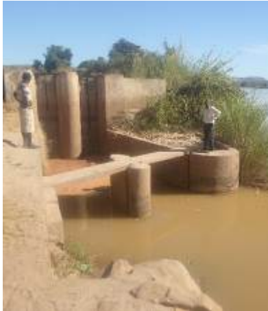
Figure 12. Ouvrage de captage au fil de l'eau
