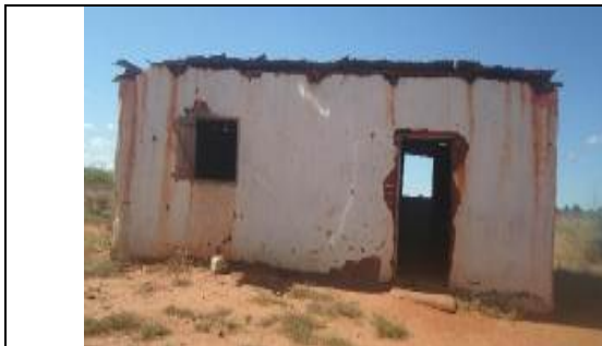
Figure 19. Bâtiment EPP en dur
