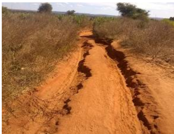
Figure 7. Piste rurale à réhabiliter
