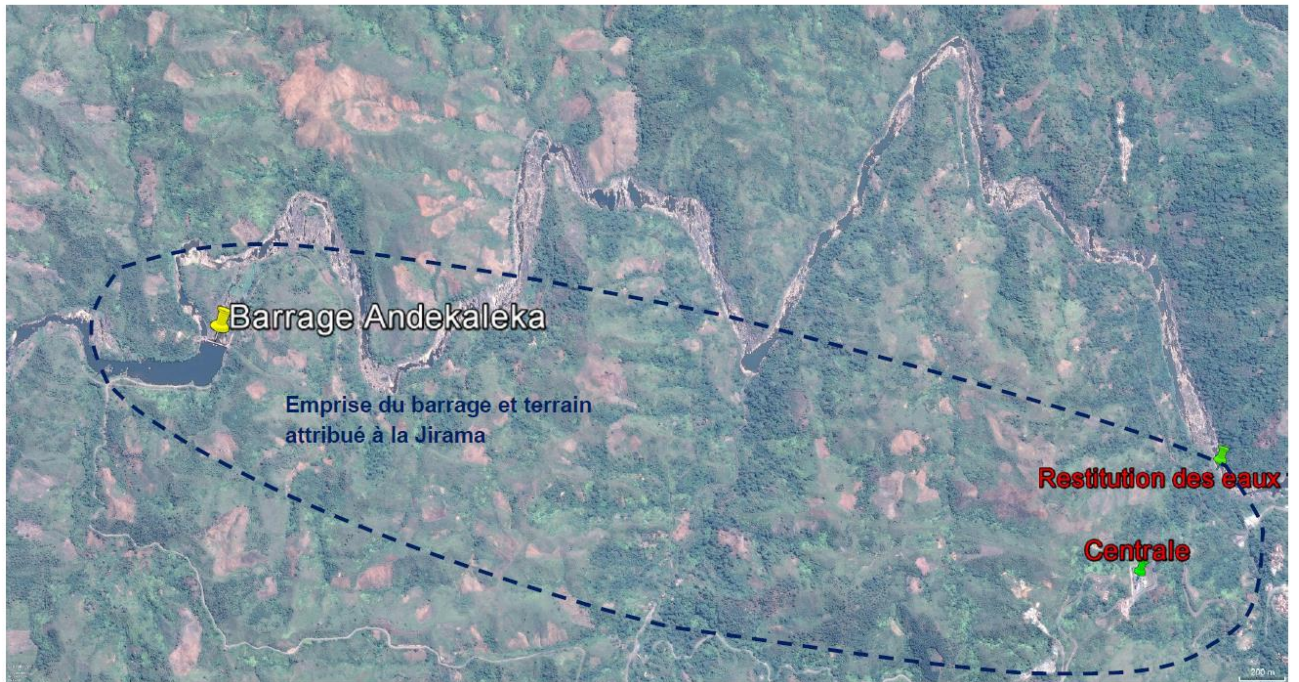
FIGURE 12 : ZONE ENTRE LE BARRAGE ET LE LIEU DE RESTITUTION DES EAUX TURBINEES
