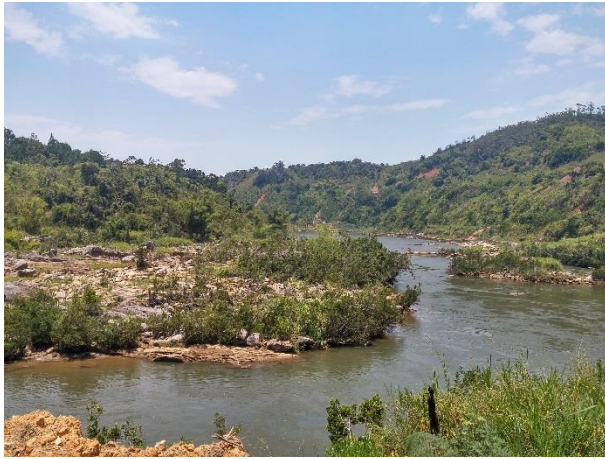
PHOTO 9 : LIT MINEUR EN AMONT DU BARRAGE
