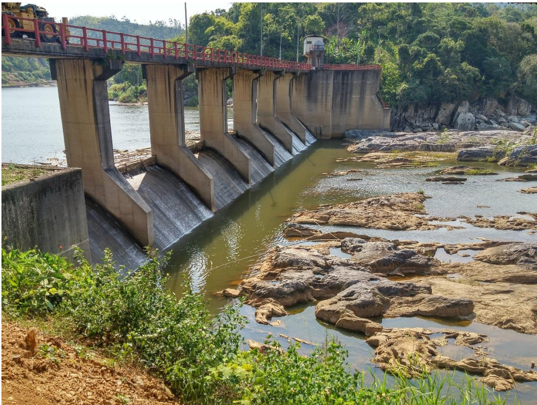
PHOTO 1 : SEUIL DEVERSANT DU BARRAGE
