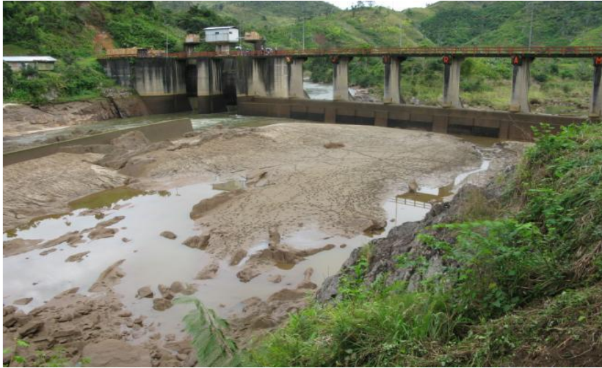
PHOTO 7 : BARRAGE - VUE EN AMONT EN PERIODE D'ETIAGE
