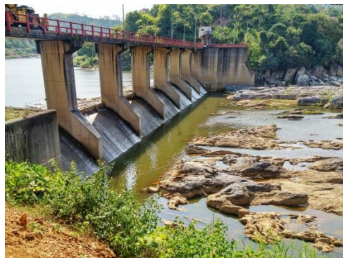
Aval du barrage
