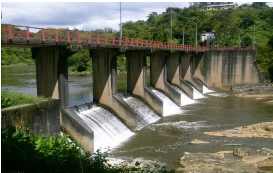
PHOTO 8 : BARRAGE – VUE EN AVAL
