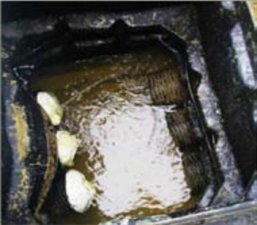
Une photographie prise à l'intérieur d'un trou d'homme, montrant une zone inondée. De la mousse blanche d'étanchéité est visible, mais elle ne semble pas avoir été correctement appliquée ou durcie, permettant à l'eau de pénétrer.               | Les problèmes de drainage devraient être résolus tôt au cours de la phase de construction. Ici, on peut voir de l'eau gicler à travers le produit d'étanchéité en mousse dans le trou d'homme inondé.       |
