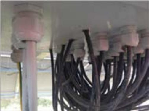
Une photographie montrant un coffret de regroupement de câbles électriques. Les câbles noirs sont entrés dans le coffret sans être protégés par des presse-étoupes, ce qui les rend vulnérables aux dommages mécaniques et à l'usure de l'isolation. | Des presse-étoupes devraient être utilisés pour tous les câbles entrant dans les coffrets de regroupement, afin d'éviter que les câbles ne bougent et d'éviter des endommagements à l'isolation des câbles. |
