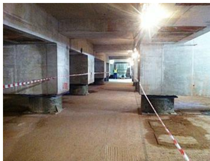
Figura 52. Schema de dispunere a sistemului de izolare la baza stâlpilor unei clădiri (stânga); dispozitive elastomerice dispuse sub stâlpi – Primăria municipiului București (dreapta)
