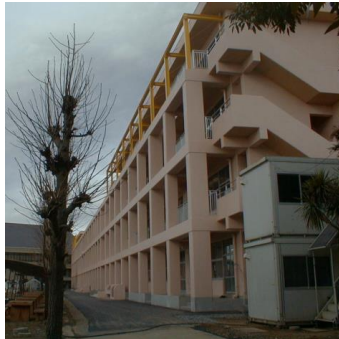
Figura 40. Cadre din beton armat conectate din exterior clădirii existente – școală în Japonia (stânga); cadre contravântuite din oțel conectate din exteriorul clădirii existente – Spitalul de urgențe, Slobozia (dreapta)
