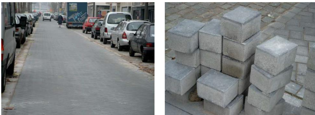
Figura 26. Pavele fotocatalitice utilizate în Antwerp, Belgia
