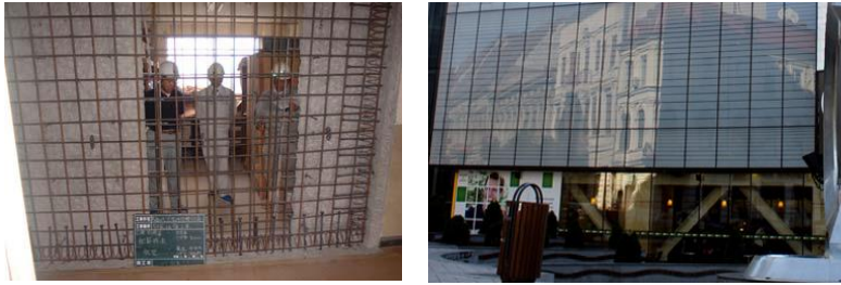
Figura 50. Construirea unui perete de beton armat într-un gol de cadru (stânga); introducerea de contravântuiri din oțel în golurile de cadru – clădirea magazinului Cocor, București (dreapta)
