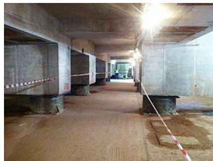
Figura 41. Schema de dispunere a sistemului de izolare la baza stâlpilor unei clădiri (stânga); dispozitive elastomeric dispuse sub stâlpi – Primăria municipiului București (dreapta)
