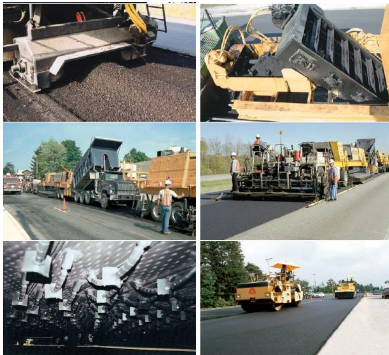
Figura 34. Reciclare la cald in situ
