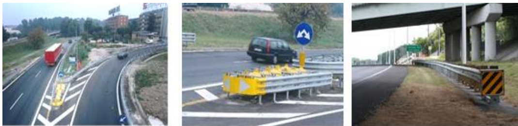
Figura 16. Sisteme tip barieră sigure cu capete corespunzătoare
