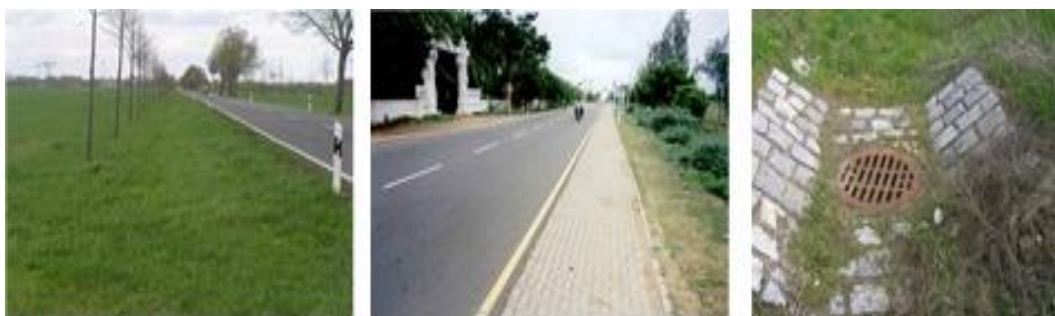
Figura 20. Sisteme permeabile de colectare a apelor pluviale
