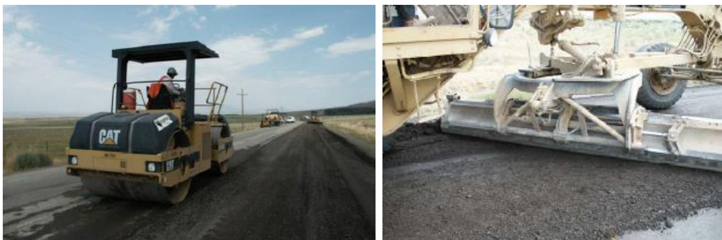
Figura 35. Reciclare la rece in situ
