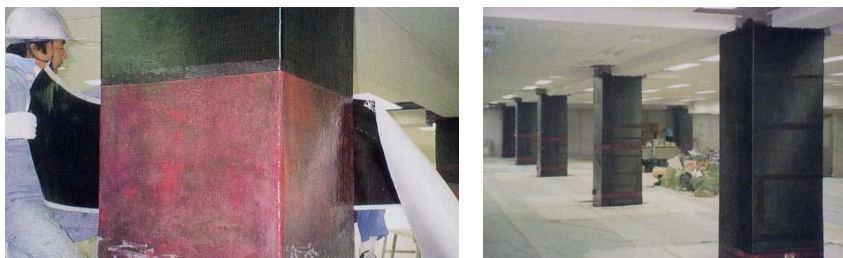
Figura 49. Cămășuirea cu fibră de carbon a stâlpilor unei clădiri de birouri (Japonia)
