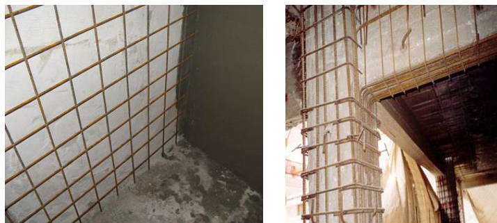
Figura 37. Tencuire armată a pereților (stânga); placare cu beton armat a grinzilor și stâlpilor (dreapta)
