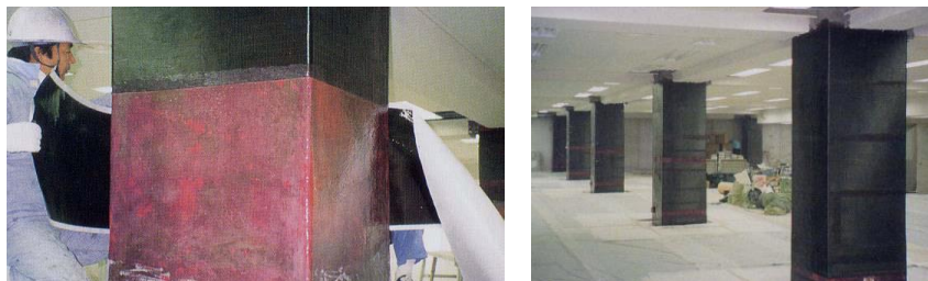
Figura 38. Cămășuirea cu fibră de carbon a stâlpilor unei clădiri de birouri (Japonia)
