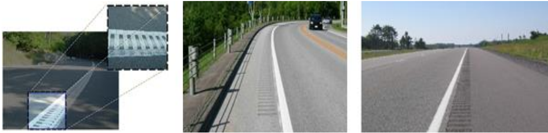
Figura 17. Suprafețe rutiere cu benzi rezonatoare de-a lungul axei drumului și marcajului lateral
