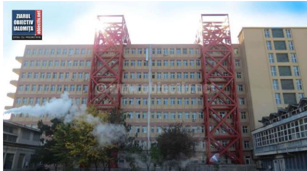
Figura 40. Cadre din beton armat conectate din exterior clădirii existente – școală în Japonia (stânga); cadre contravântuite din oțel conectate din exteriorul clădirii existente – Spitalul de urgențe, Slobozia (dreapta)
