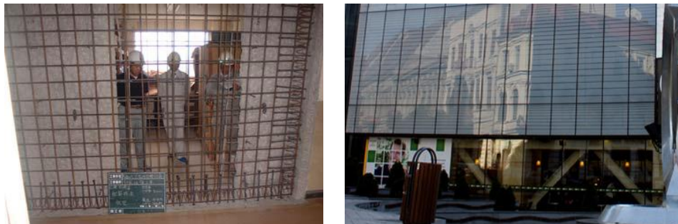
Figura 39. Construirea unui perete de beton armat într-un gol de cadru (stânga); introducerea de contravânturi din oțel în golurile de cadru – clădirea magazinului Cocor, București (dreapta)
