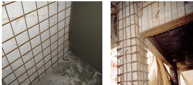
Figura 48. Tencuire armată a pereților (stânga); placare cu beton armat a grinzilor și stâlpilor (dreapta)
