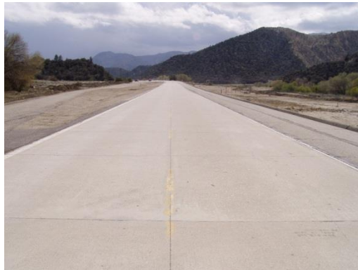
Figura 27. Îmbrăcămințe rutieră din beton de ciment
