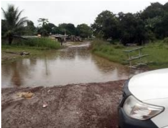
Photo 10 –vue de l'état de la route et des maisons en bois à Iwosso
