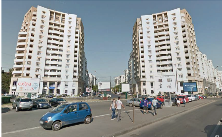
Planșa 1.3 Blocurile-turn Gemeni din București, Piața Națiunile Unite, utilizate pentru locuințe de necesitate.
