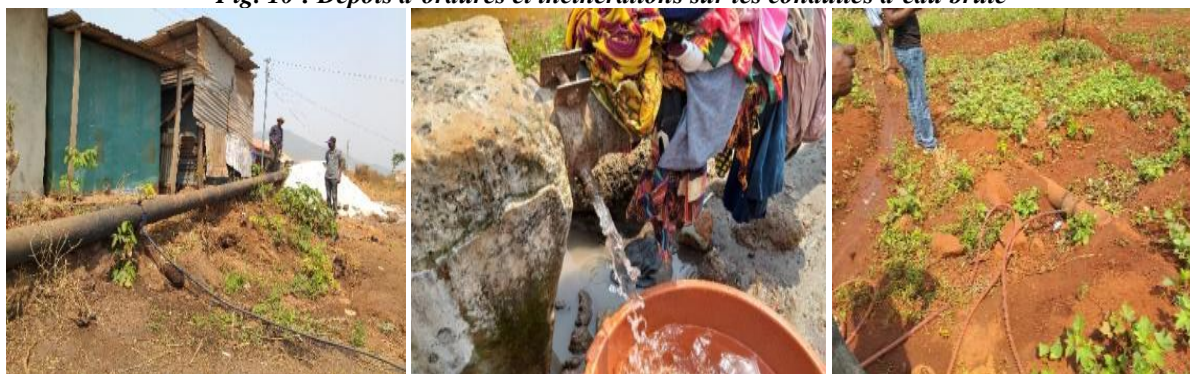
Fig.11 : Piquages anarchiques sur les conduites d'eau brute et d'eau traitée pour divers usages (consommation, travaux domestiques, activités commerciales/artisanales, irrigation des cultures)
