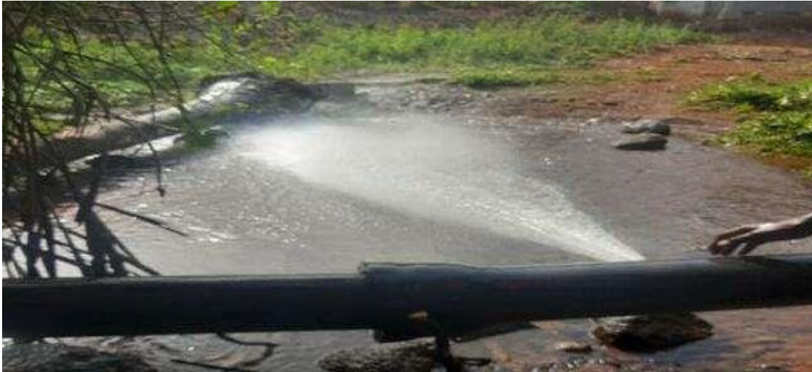
Fig. 6 : Piquages sur les conduites d'eau brute en apparence
