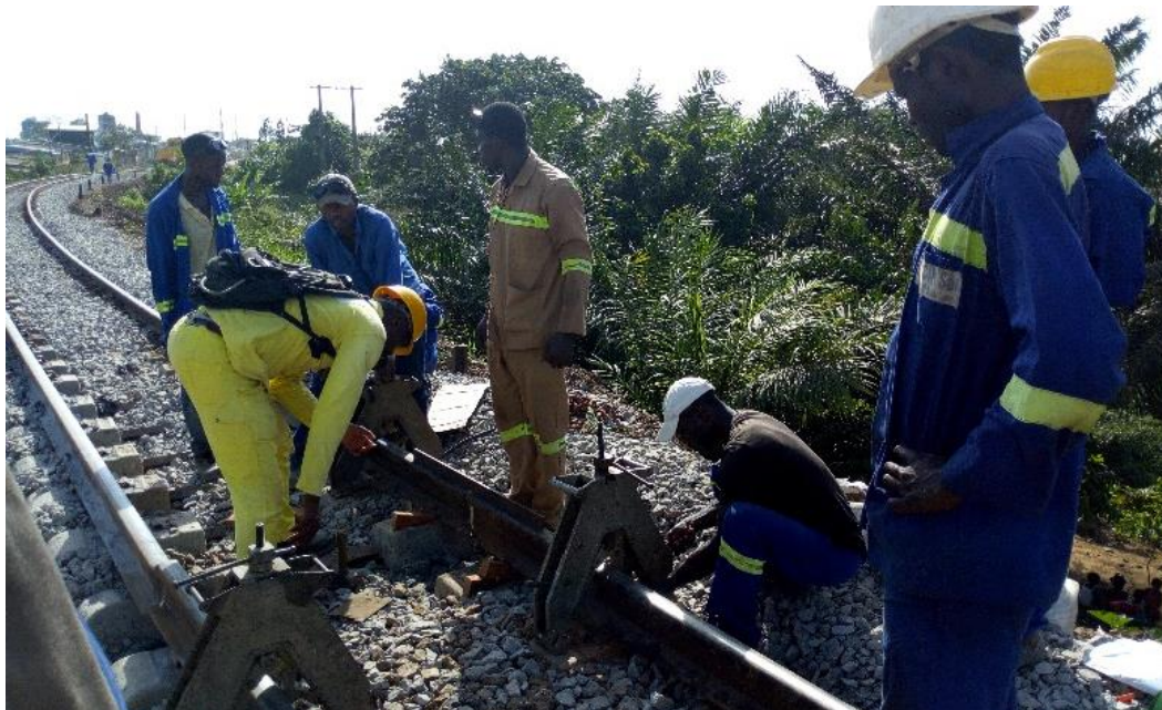
Photo 41 :Vue du soudage aluminothermique
