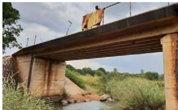
1. Pont dalle à poutrelles enrobées
