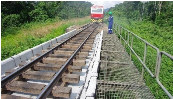
5. Travaux d'étanchéité sur deux ponts
