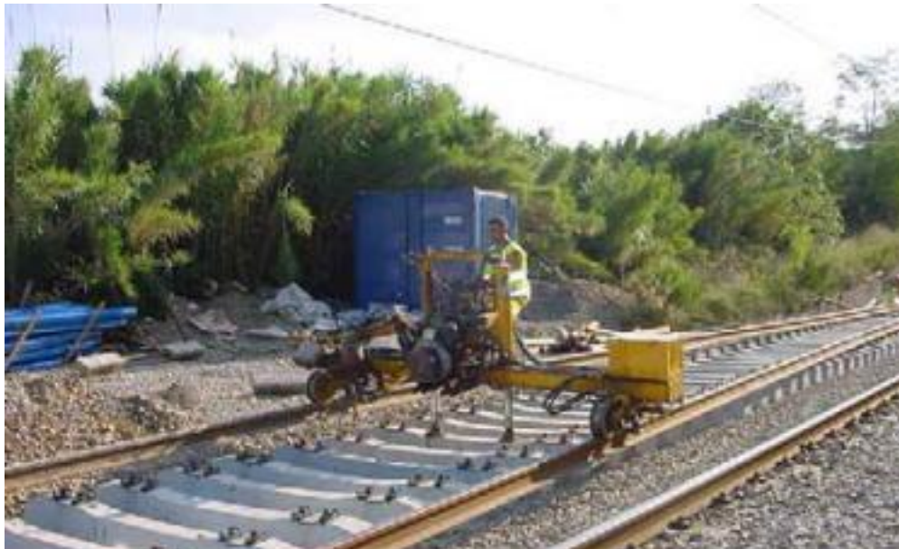
Photo 37 : Positionneur de rail
