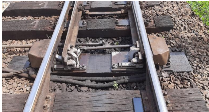
Photo 30: 18 BS 50 KG sur voie directe, équipé de verrou carter coussinet
