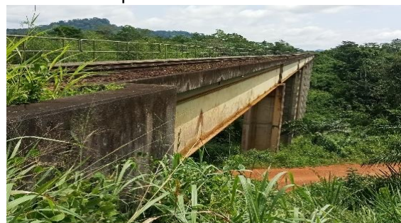
3. Pont en béton armé type viaduc
