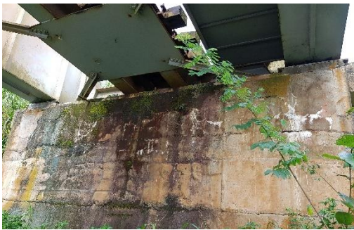
1. Vue d'une culée d'un pont métallique
