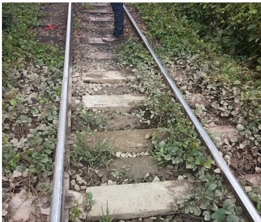
(a) Une zone de remontée de glaise à la suite du poinçonnement de la plateforme
