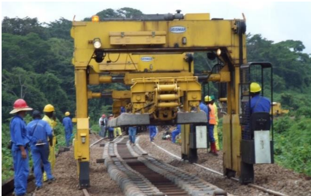
Photo 36 : Portique de renouvellement pour pose de traverses
