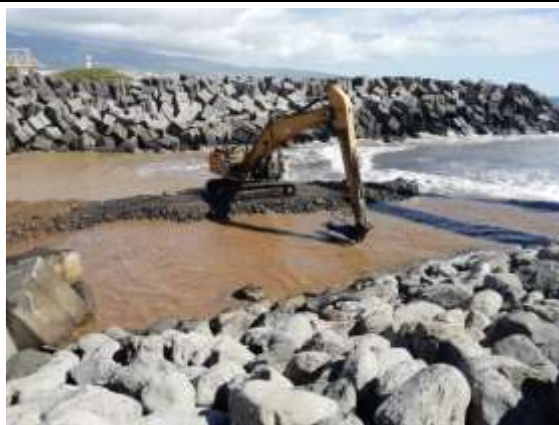
Photo 10: Pelle terrestre à bras long
