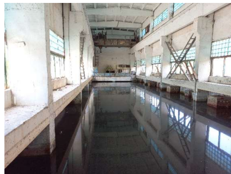
Фото. 4. Подстанция насосной станции ГНС-3 и ГНС-3а (слева) и затопленный ГНС-3 (справа)
