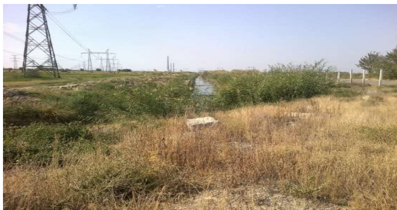
Фото. 2. Состояние КДС в Зафарабадском районе
