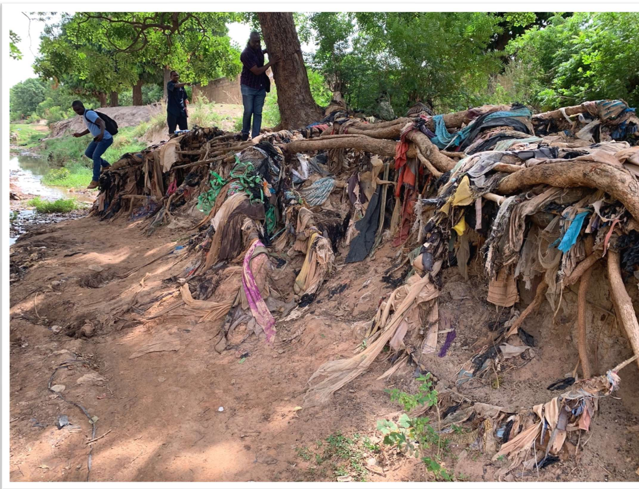
Photo 5 : Effet de l'érosion sur les berges de l'exutoire des canaux de l'arrondissement 5
