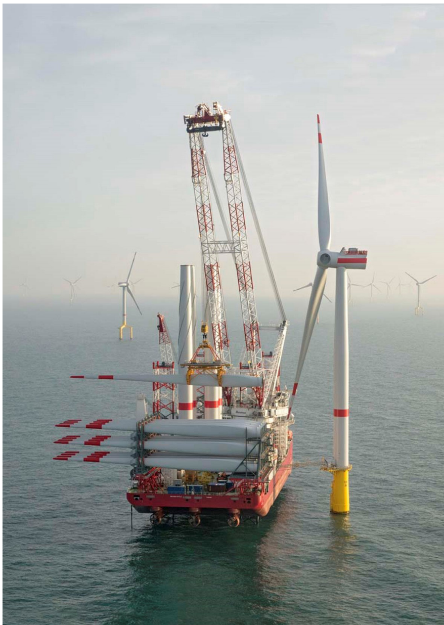
FIGURA C7.5 EXEMPLU DE NAVĂ DE INSTALARE A TURBINEI
