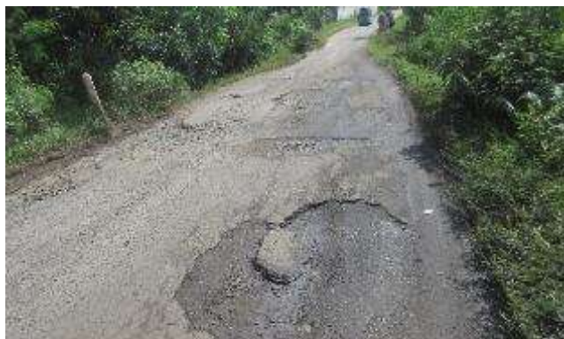
Figure 5 : Situation de la chaussée du PK 44+000 au PK 55+000
