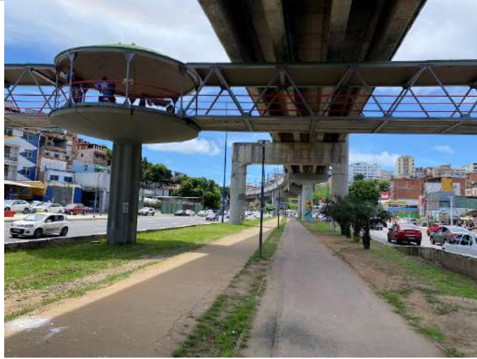
Figura 16 – Dificuldade de acesso na ciclovía da Av. Mário Leal Ferreira (falta de rampa desde a passarela)
