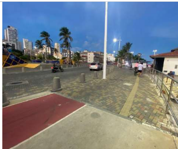
Figura 40 – Falta de sinalização do fim da ciclovia na Praça Nossa Senhora da Paz
