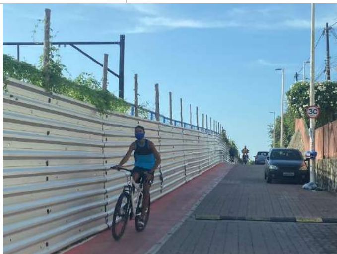
Figura 91 - Ciclovía na Av. R. Almeida Brandão (Itacaranha/Plataforma - largura insuficiente para ser bidirecional)
