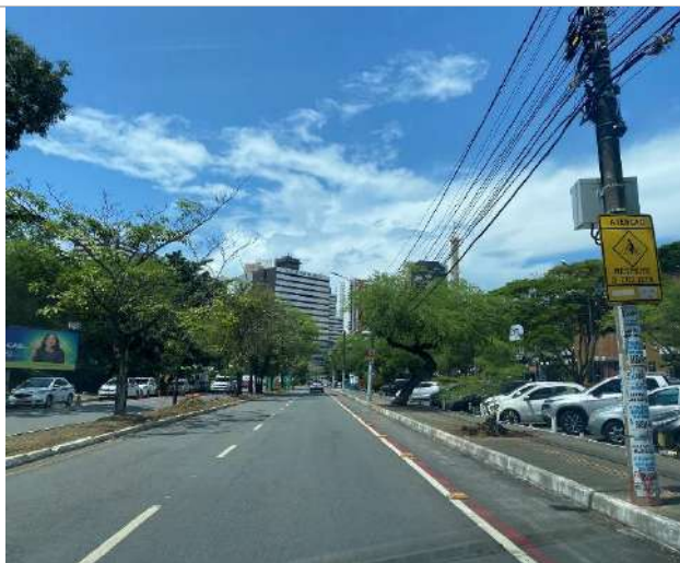
Figura 92 - Ciclovia na R. Anísio Teixeira (Itaigara - largura insuficiente para ser bidirecional)
