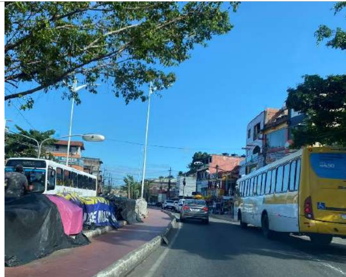
Figura 24 – Largura da ciclovia unidirecional de 0,70m na ciclovia da Av. Afrânio Peixoto (Calçada/Plataforma/Periperi/Paripe)
