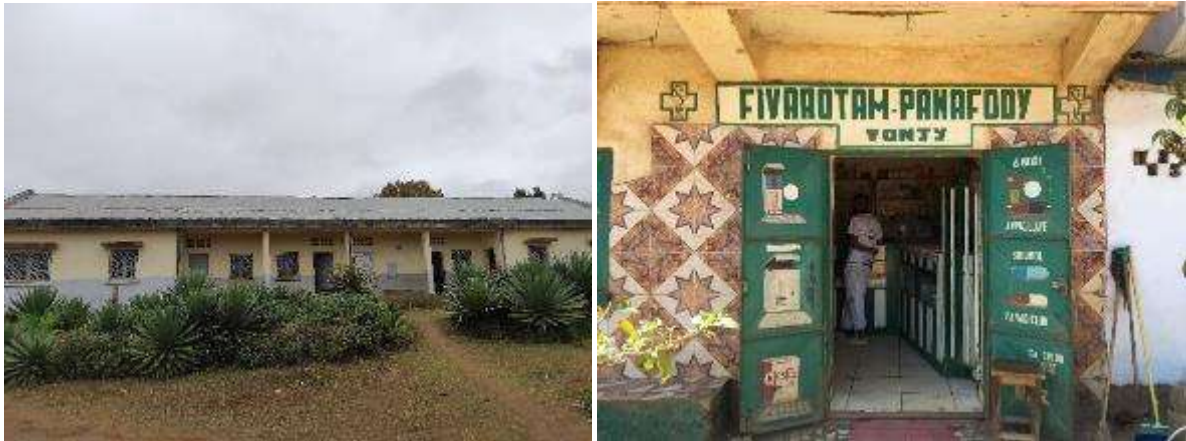
Photo 36. Centre de santé de base et Dépôt de médicament à Bealanana
