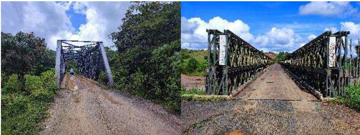
Photo 7. Ponts existants à démolir et à remplacer en pont en BA
