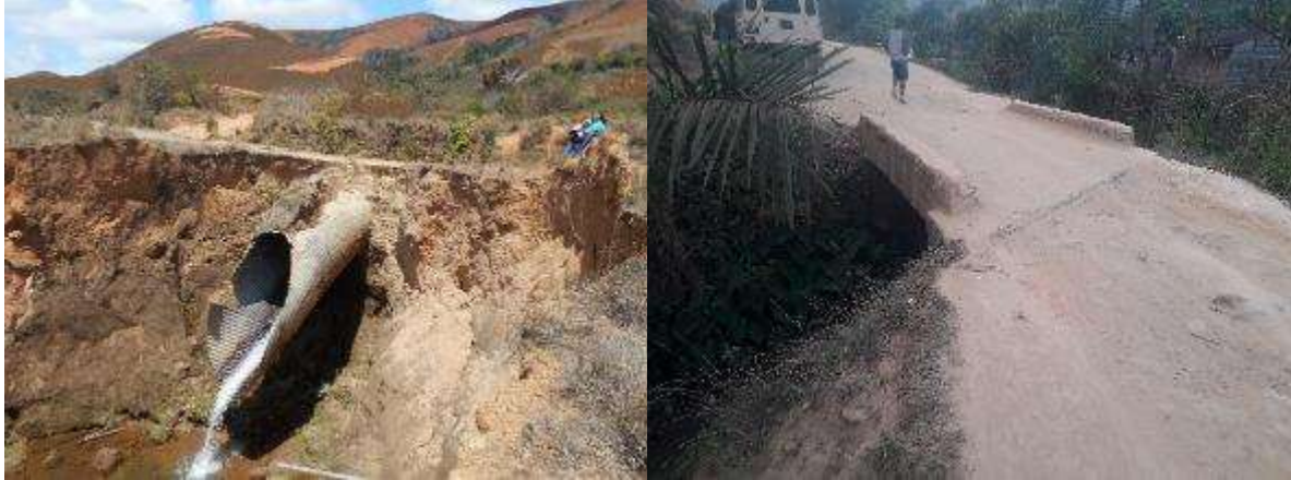
Photo 8. Aperçu des ouvrages de franchissements existants
