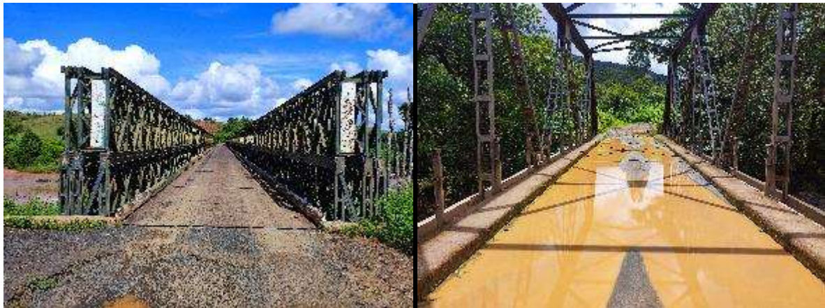
Photo 13. Exemples de ponts à remplacer en pont en BA
