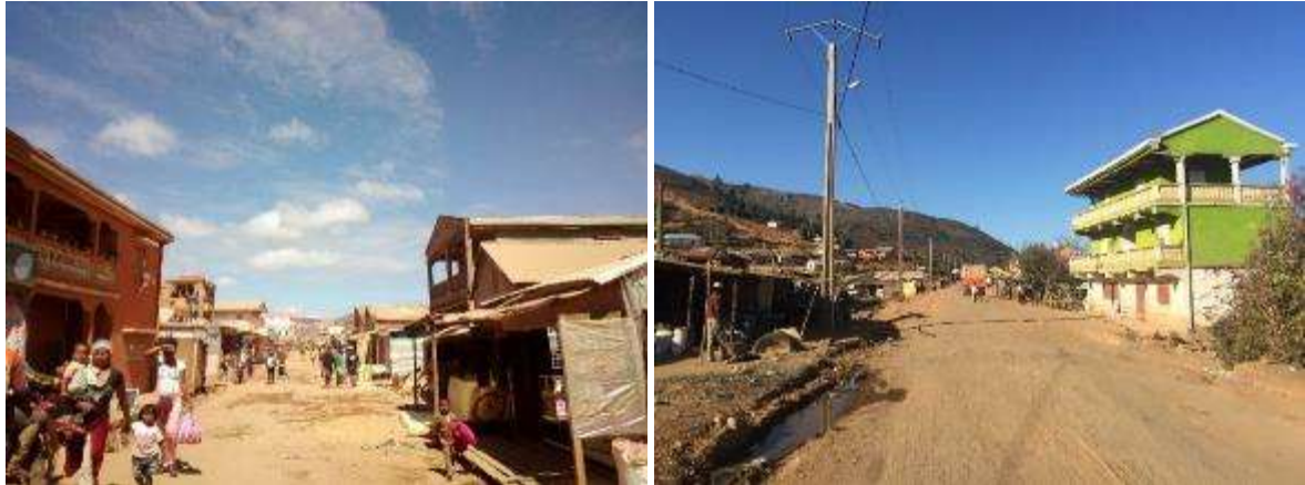
Photo 32. Typologie des constructions au niveau des chefs lieu de commune (Antsahabe et Ambodiampana)
