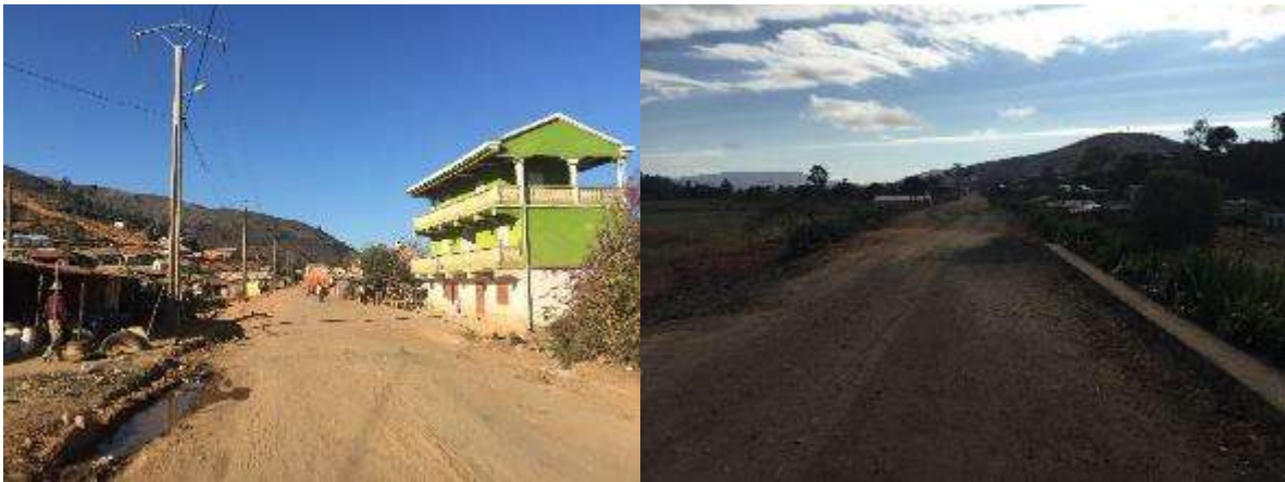
Photo 10. Aperçu de la largeur de la route existante supérieur à 7m dans la région d'Ambodiampana et Ambatosia
