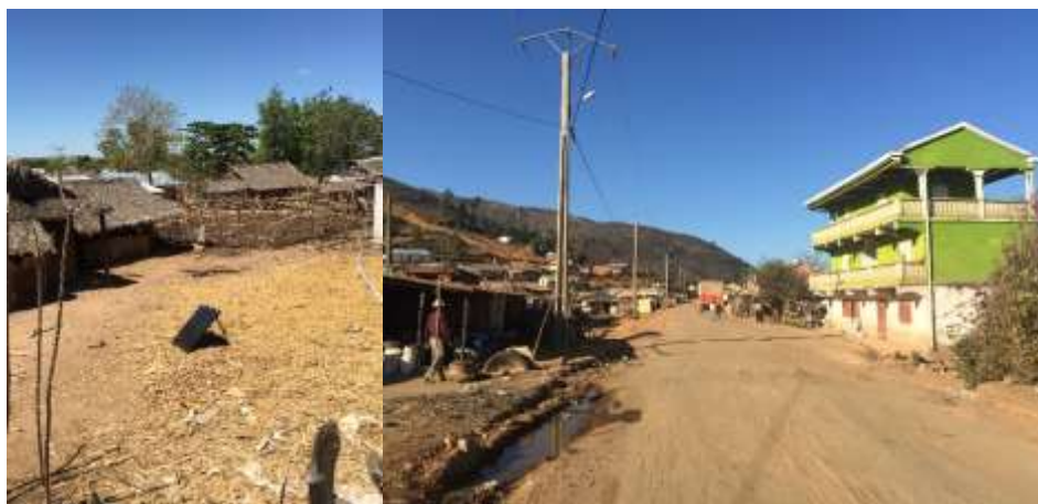
Photo 39. :Source d'énergie dans la zone du projet : Panneau solaire (Ambodimandresy) et réseau de la JIRAMA à Ambodiampana.
