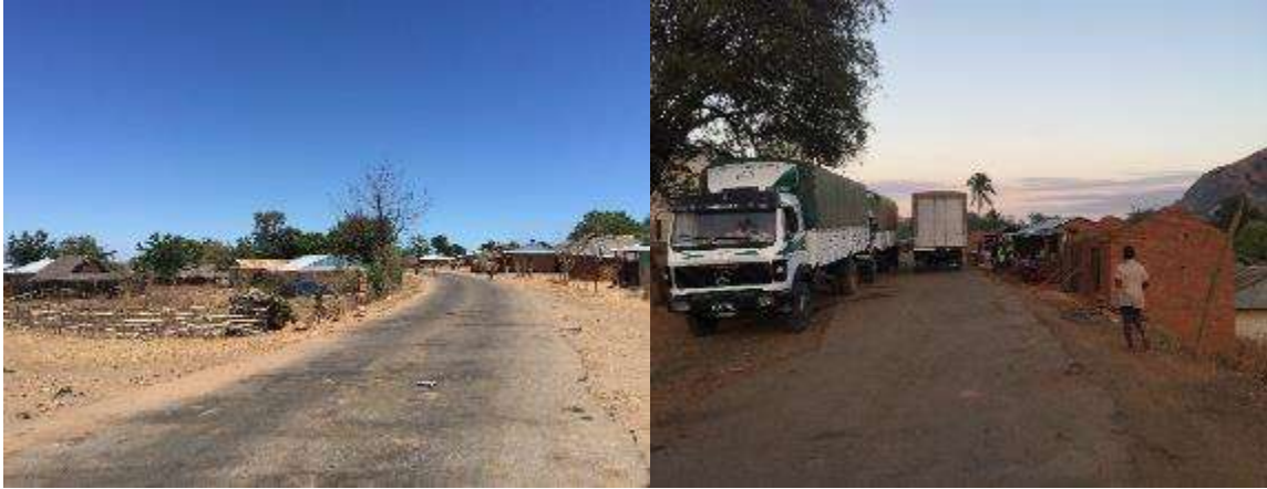
Photo 9. Aperçu de la largeur actuelle (4 à 5m) des tronçons revêtus à Ankazobetsihay et Antsahabe
