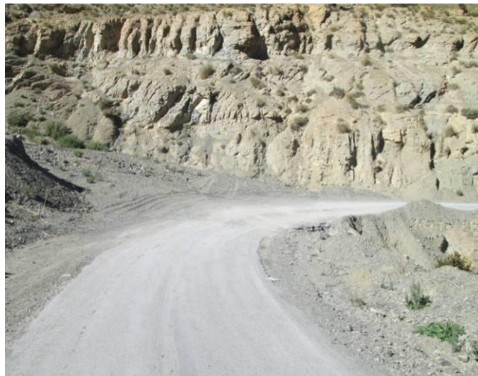
Figure 84 : Zone de charriage (PK49+500)
