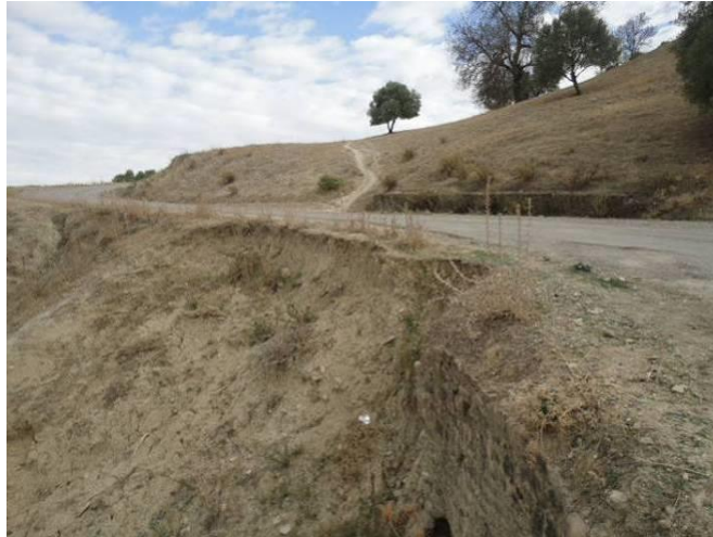
Figure 46 : Débordement des eaux sur la route au PK 55+400
