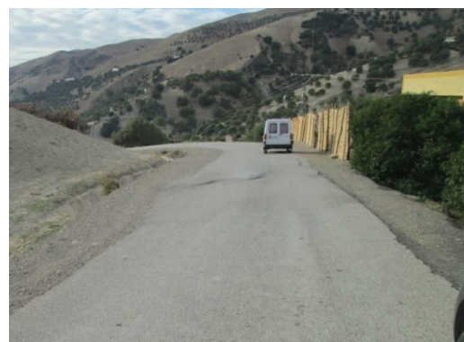
Figure 58 : Fissuration longitudinale et transversale et affaissement de la chaussée côté remblai-(PK53+500)
