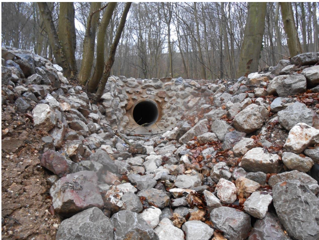
Figure 150 : Exemple d'une protection en sortie d'ouvrage constitué d'enrochements liés au béton au débouché de la buse et d'un tapis d'enrochements libres.
