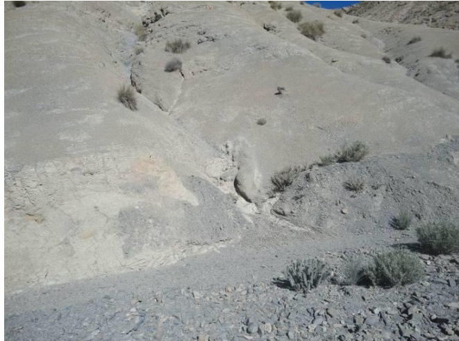
Figure 74 : Absence de captage au PK 75+500
