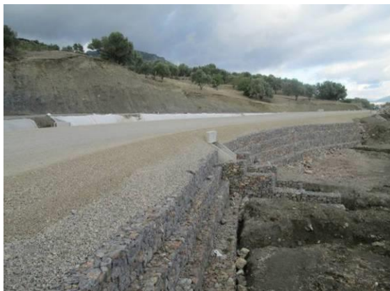
Figure 30 : Confortement du talus aval de la chaussée
