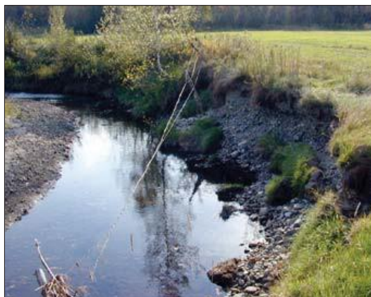
Figure 130 : Exemple du pouvoir érosif de l'eau sur la berge d'un cours d'eau
