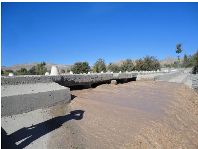
Figure 78 : Ouvrage sous dimensionné sur l'oued Ziz au PK 93
