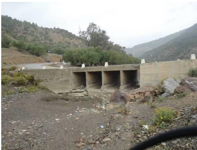
Figure 49 : Fosse d'affouillement à la sortie de l'OH au PK 88+000
