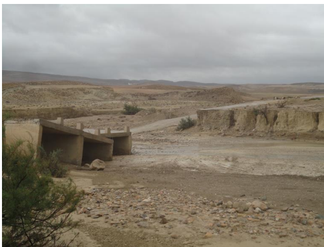
Figure 54 : OH détruit sur l'oued Boulswab au PK 158+150
