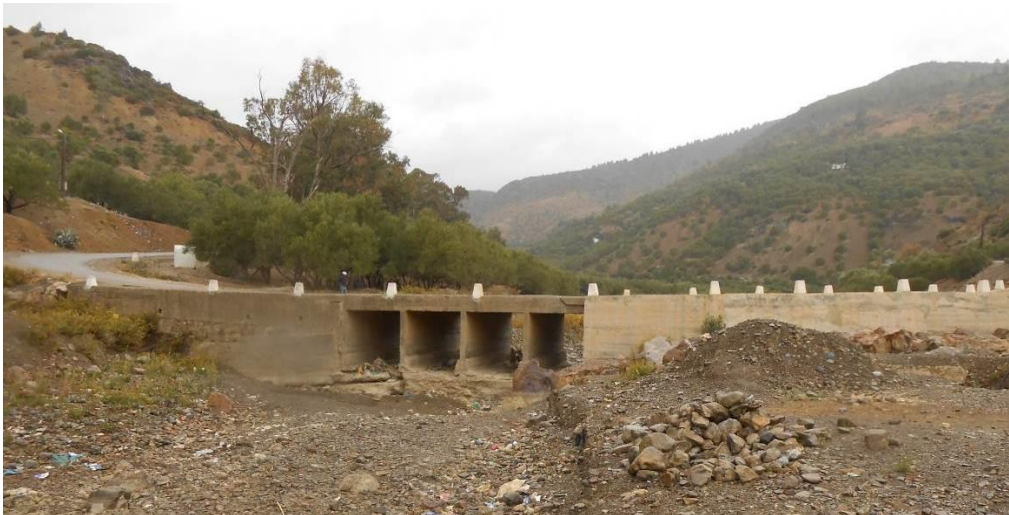
Figure 120 : Exemple de pont submersible sur la RR508
