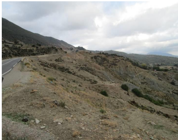
Figure 160 : Glissement de terrain de la section 133+800 – 134+500 de la RN 2
