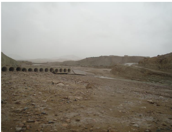
Figure 53 : OH détruit sur l'oued Boulswab au PK 137+630
