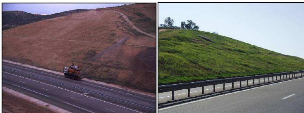
Végétalisation par hydroseeding
