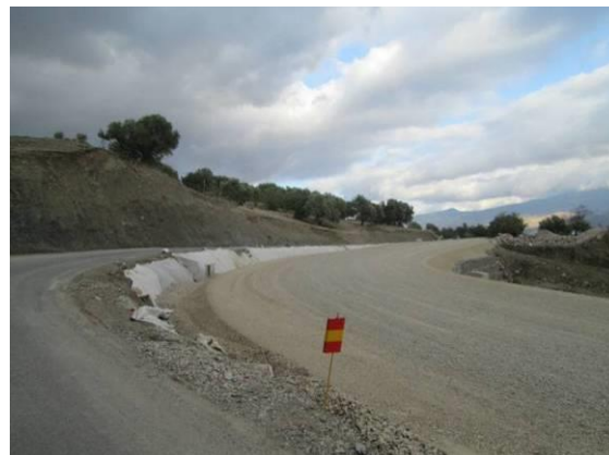
Figure 31 : Travaux de réparation de la route en cours
