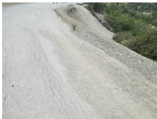
Figure 58 : Fissuration longitudinale et transversale et affaissement de la chaussée côté remblai-(PK53+500)
