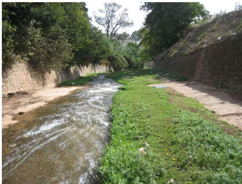
Figure 12: Exemple de traitement des berges en maçonnerie - Berges de l’Oued Aggay (Sefrou)
