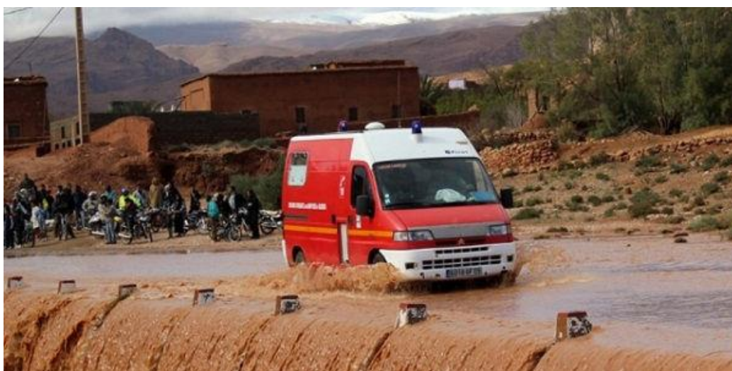
Figure 127 : Exemple de circulation sur un pont submersible submergé par une crue d'un oued lors des inondations de novembre 2014
