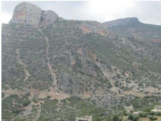
Figure 24 : Zone de chute de blocs (PK142+200 – 143+900)
