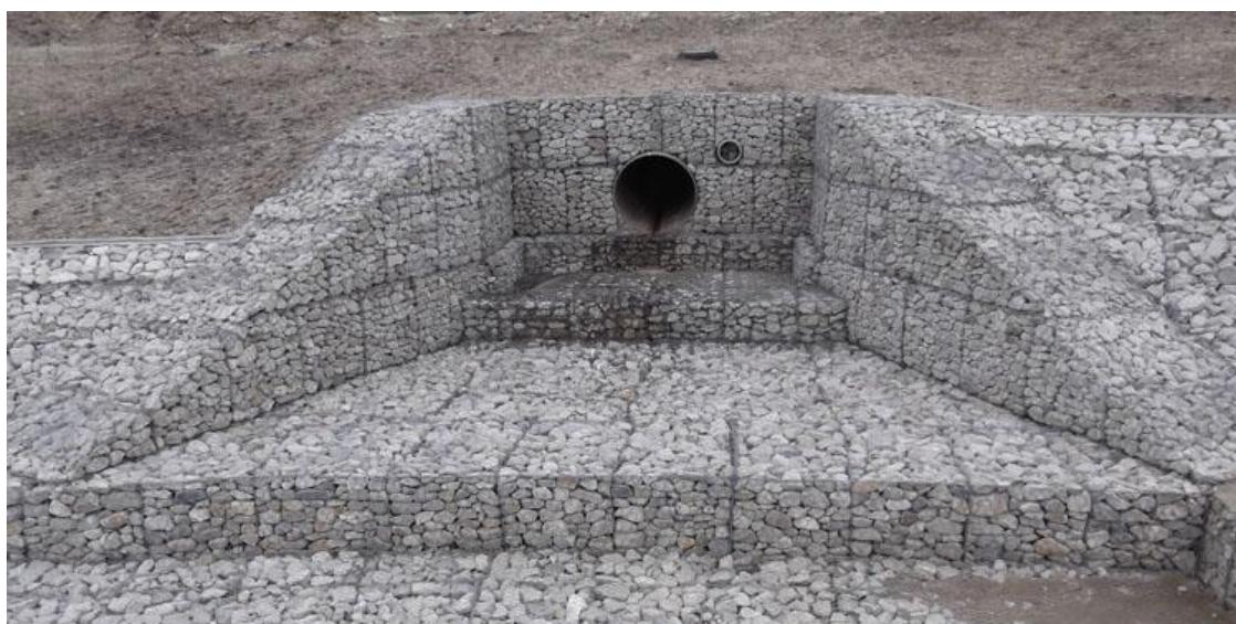
Figure 150 : Exemple d'une protection en sortie d'ouvrage constitué d'enrochements liés au béton au débouché de la buse et d'un tapis d'enrochements libres.
