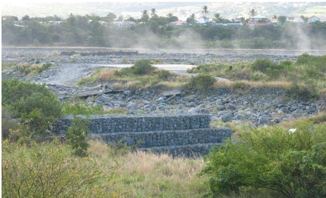
Figure 140 : Exemple d'épis en gabion.
