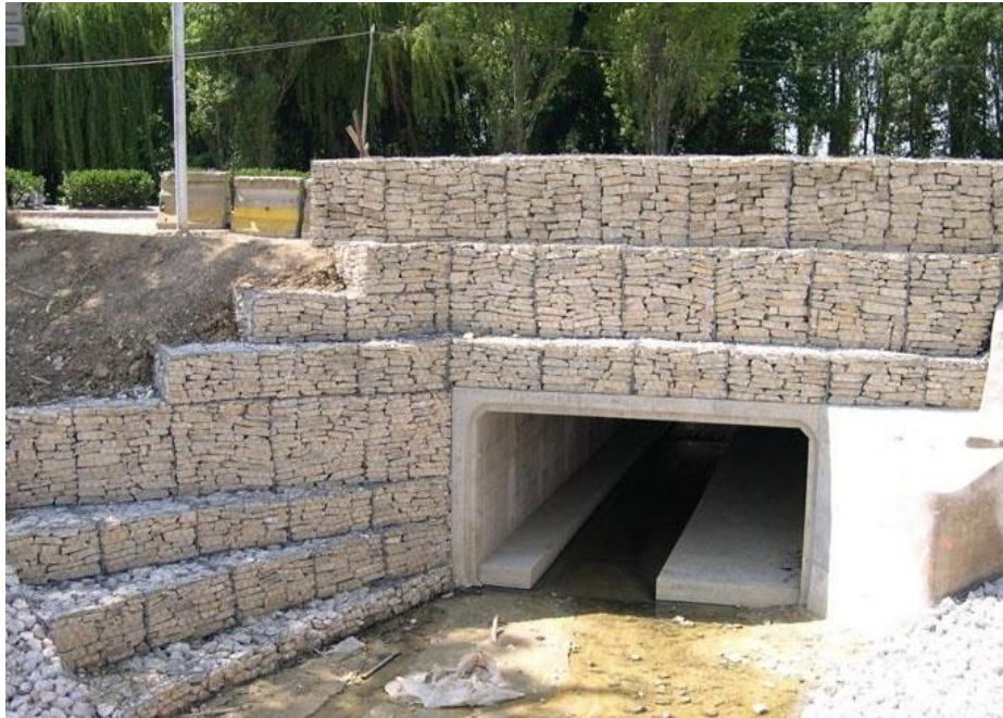
Figure 151 : Exemples d'aménagement d'ouvrages de tête en gabions
