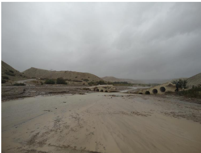
Figure 52 : OH détruit sur l'oued Msoun au PK 131+362
