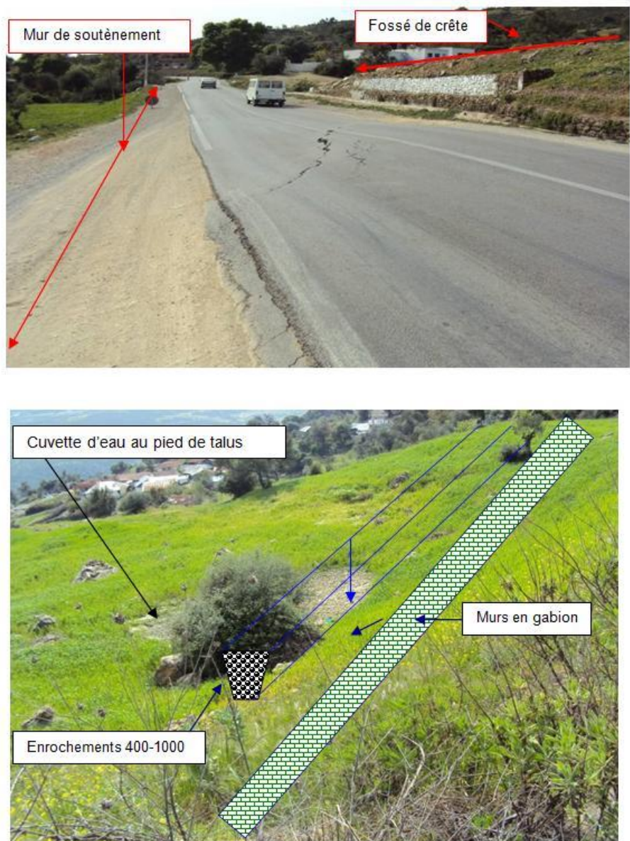
Figure 32 : Reportage photographique au droit du désordre au PK130+900 et des solutions retenues
