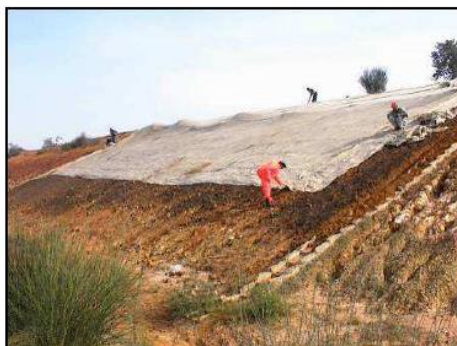
Installation Terre végétale, semis, engrais et géotextile
