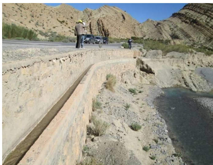
Figure 90 : Confortement par mur en maçonnerie (PK62+500)
