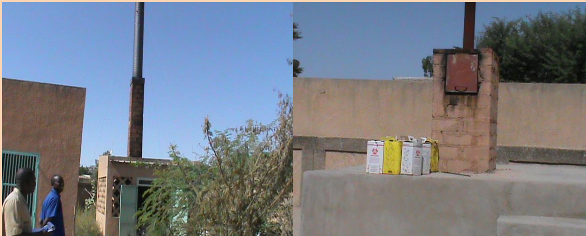
Photo 25 et 26 : HNZ : l'incinérateur et le brûleur des Boîtes de sécurité
