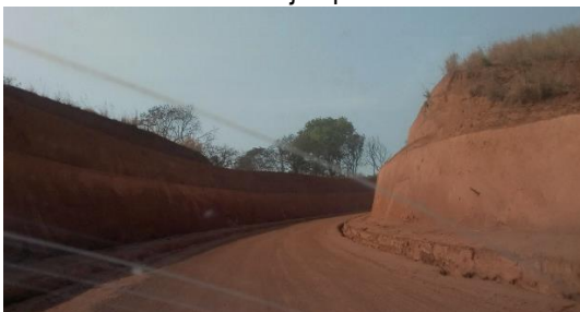
Photo 13: Vue du terrassement de l'axe Lena-Tibati
