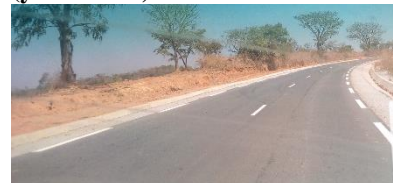
Photo 22: Vue tu tronçon bitumé (yoko-Lena)
