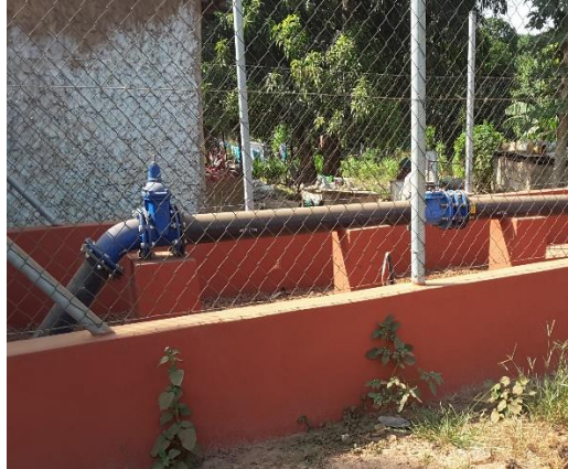
Photo 2: Forage réalisé à Granja Pessube
