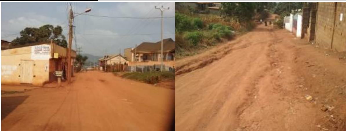
Photo 4 : Présence des maisons d'habitation et du réseau électrique sur l'emprise du Projet dans la CAY 7
