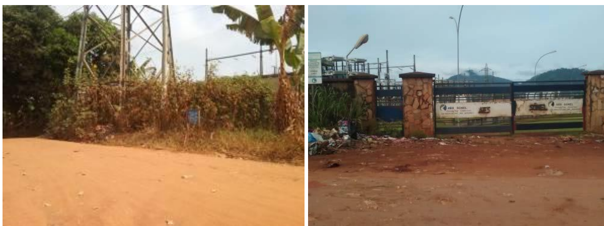
Photo 5 : Présence des installations du Camp SONEL OYOM-ABANG dans l'emprise du Projet
