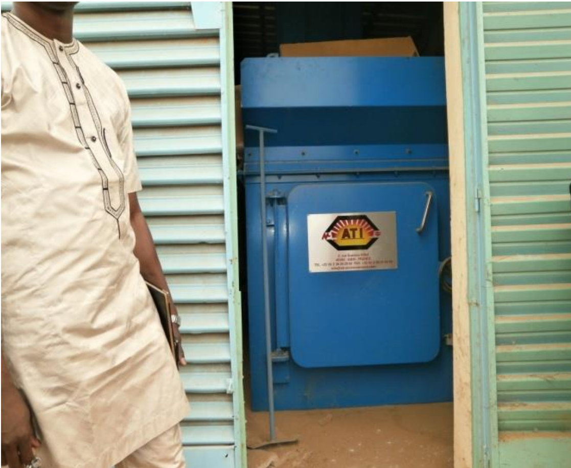
Incinérateur conventionnel ATI acquis depuis 2016 par SAVE THE CHILDREN et non fonctionnel
