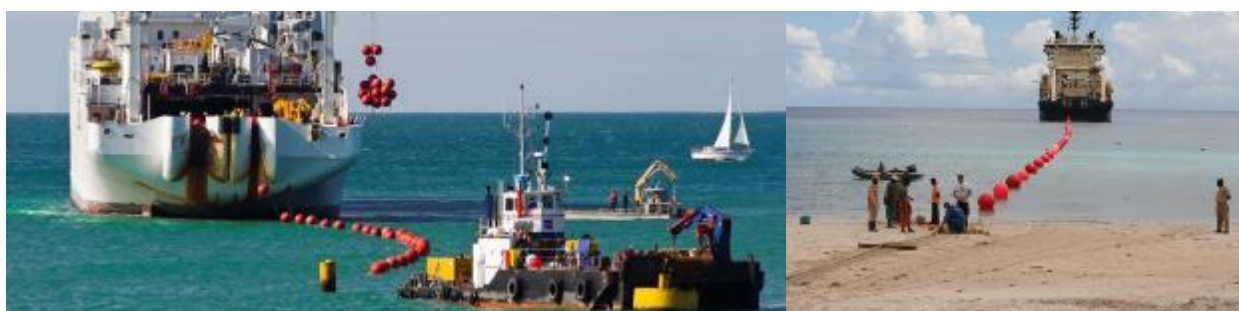
Photo 3: Raccordement du câble à la station finale (atterrissage à la plage)
