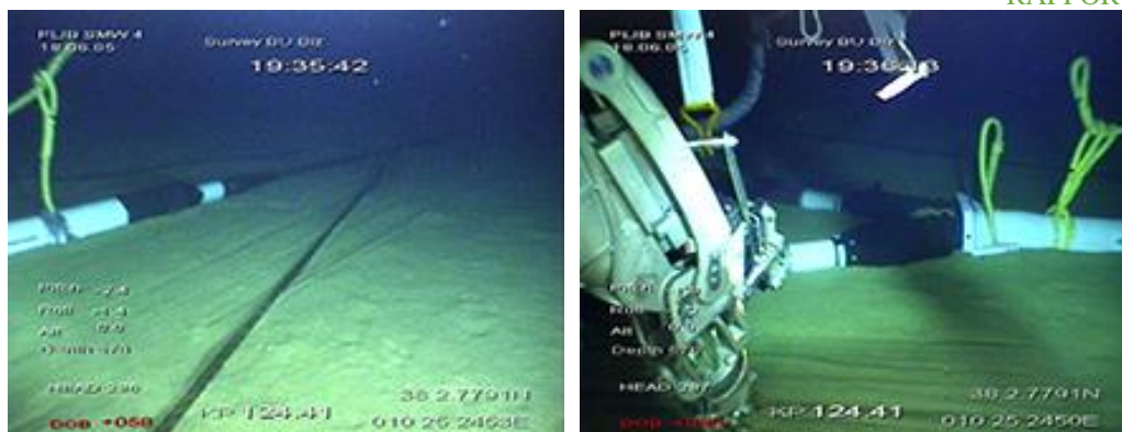
Photo 2: Raccordement du câble à la station finale
